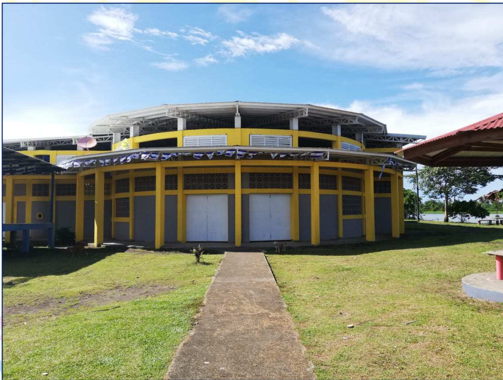
En la fotografía se observa la ejecución de la III Etapa del proyecto Rehabilitación del Polideportivo Alexis Arguello, en el cual se aprecia la instalación de ventanas metálicas tipo louvers y aplicación de la pintura en paredes.
